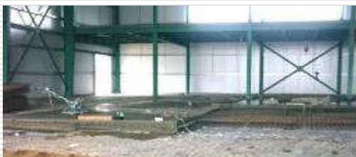
Установка арматурных сеток
